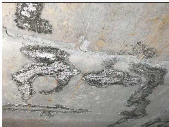
Рисунок 7 – Следы замачивания перекрытия (2 этаж)
