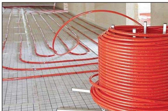
Рисунок 1 – Укладка труб из сшитого полиэтилена в теплый пол
