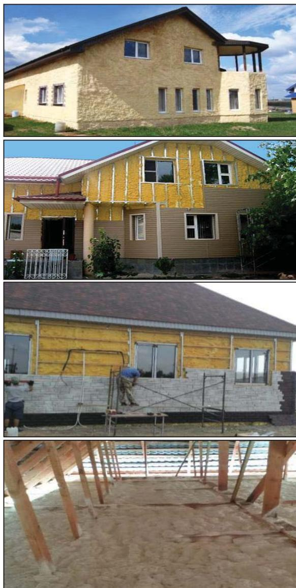
Рисунок 4 – Варианты применения пенополиуретана при утеплении индивидуальных домов в Алтайском крае
