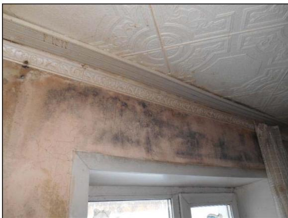
Рисунок 9 – Грибок черного цвета в жилой комнате одной из квартир над оконным проемом
