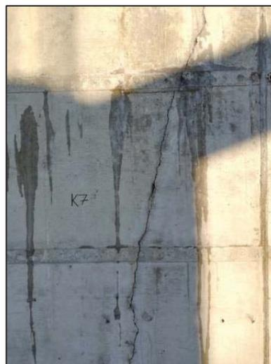
Рисунок 2 – Вертикальная трещина в колонне
