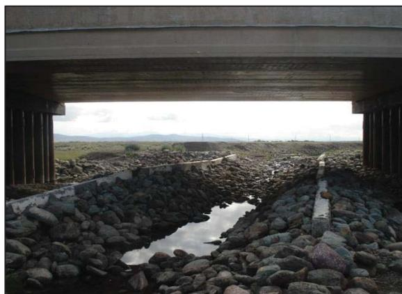
Рисунок 2 – Углубление русла реки Черная автомобильной дороге Р-256 «Чуйский тракт» км 889+522
