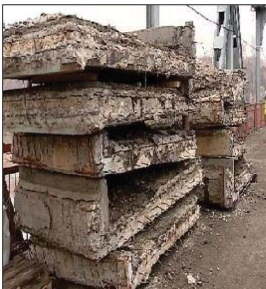
Рисунок 2 – Плиты проезжей части моста
