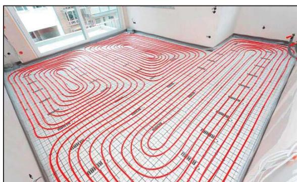
Рисунок 5 – пример укладки теплого пола
