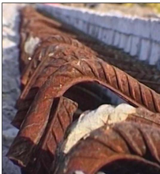
Рисунок 3 – Оголенная арматура проезжей части моста
