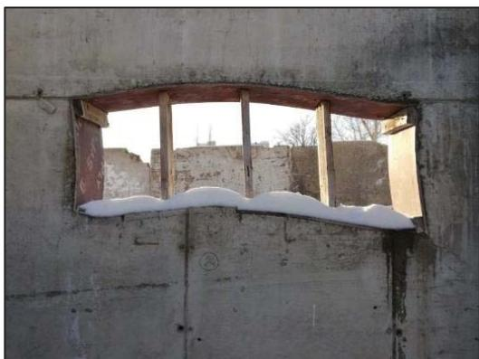
Рисунок 4 – Отклонение от прямолинейности и плоскостности поверхности откосов оконного проема
