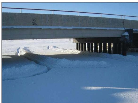
Рисунок 1 – Пример применения водоотводных канав во льду наледи на реке Черная автомобильной дороге Р-256 «Чуйский тракт» км 889+522
