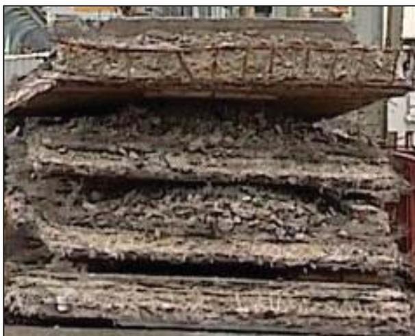
Рисунок 1 – Вид разрушенных плит проезжей части моста
