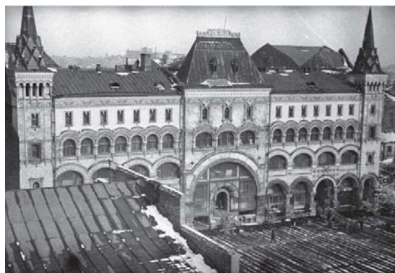
Рисунок 2 – Процесс переезда Саввинского подворья
