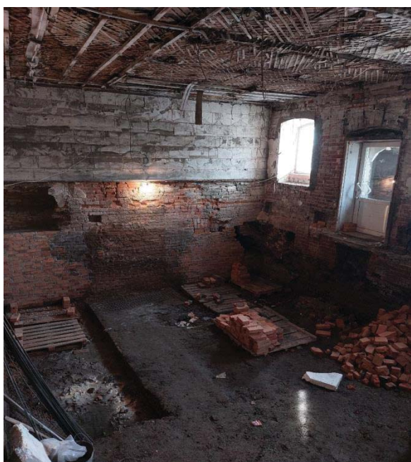
Рисунок 2 - Восстановление поврежденных участков кирпичных стен
