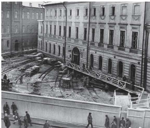
Рисунок 4 – Переезд здания Моссовета
