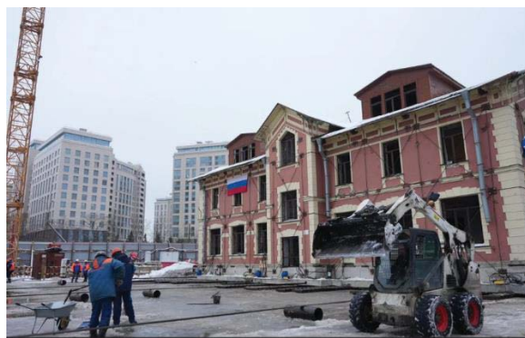
Рисунок 6 – Подготовка здания корпуса Императорского воспитательного дома к переезду
