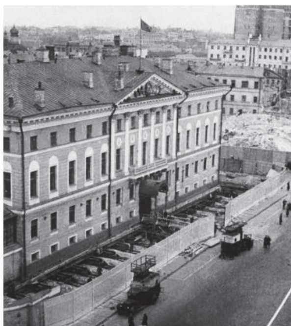
Рисунок 3 – Переезд здания Моссовета
