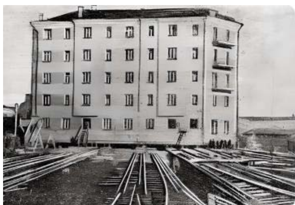
Рисунок 1 – Процесс переезда дома на улице Серафимовича
