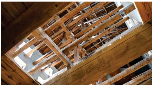
Рисунок 3 – Сохранившиеся части деревянных перекрытий
