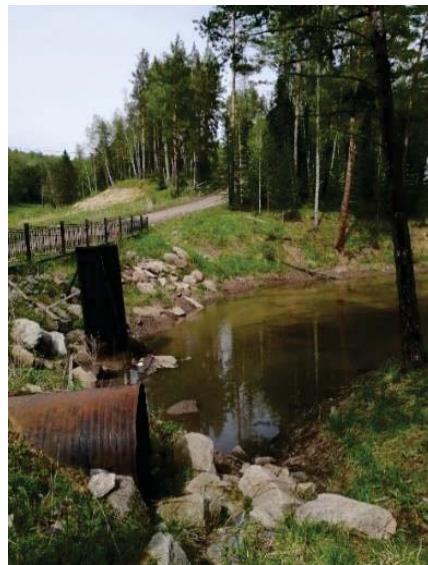
Рисунок 26 – Благоустройство территории горнолыжного спуска «Мишина гора». Фото автора
