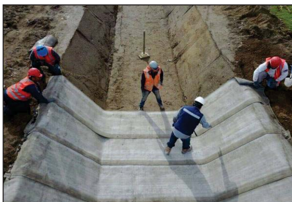
Рисунок 5 – Укрепление траншеи бетонным полотном
