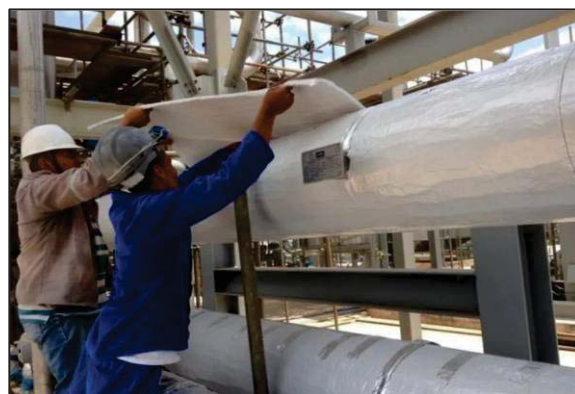
Рисунок 3 – Монтаж и фиксация изоляции из аэрогеля на трубопроводе
