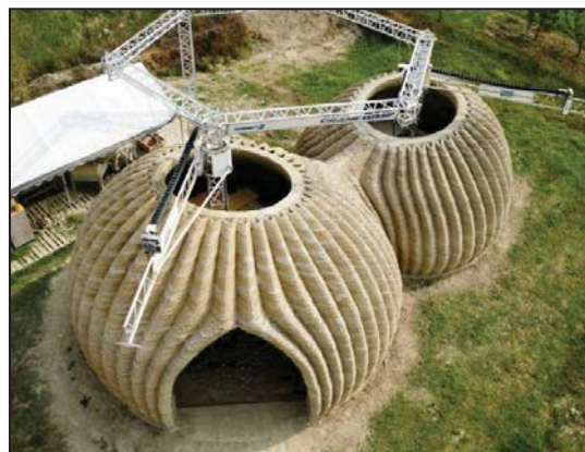
Рисунок 1 – Эко-жилой дом Tecla, напечатанный на 3D-принтере из глины
