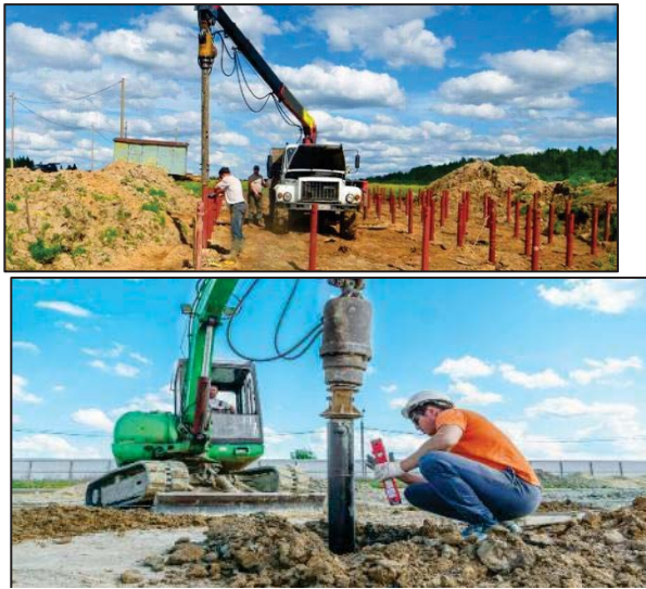
Рисунок 4 – Монтажное механизированное оборудование
