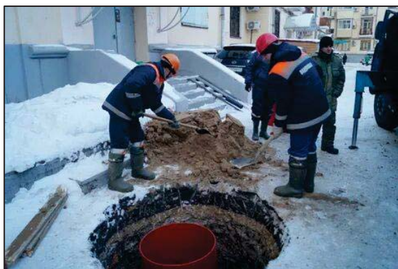
Рисунок 2 – Установка полимерного колодца в подготовленную шахту
