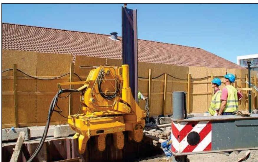
Рисунок 2 – Установка для статического вдавливания шпунта в условиях ограниченного пространства
