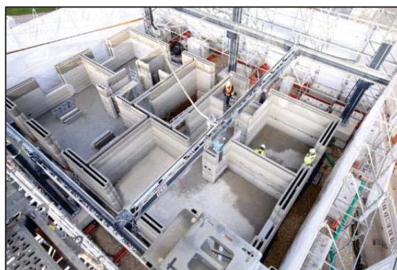
Рисунок 1 – Монолитная 3D-печать
