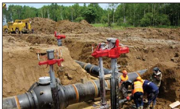
Рисунок 3 – Прокладка полиэтиленовых труб мерными отрезками
