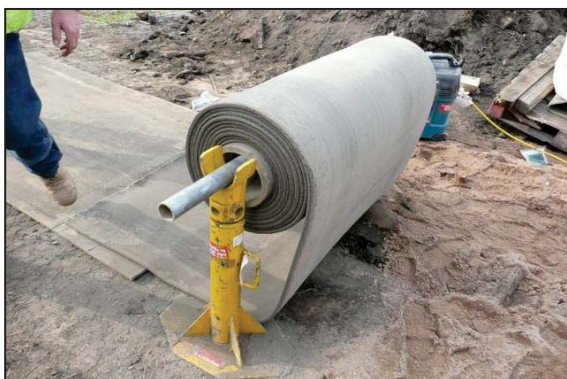
Рисунок 3 – Устройство бетонного полотна в проектное положение
