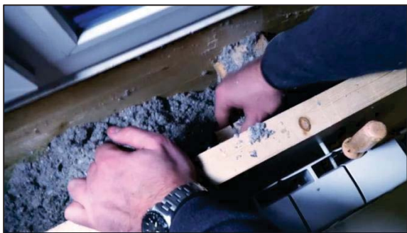
Рисунок 3 – Усадка утеплителя (эковаты) на величину до 10 см, видимая после снятия подоконной доски
