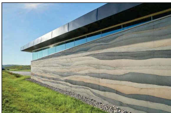
Рисунок 8 – Землебитная стена с использованием пигментирующих добавок (на примере комплекса по переработке отходов в Канаде)
