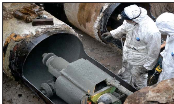
Рисунок 2 – Машина для нанесения цементно-полимерной смеси внутри теплопровода
