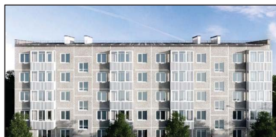
Рисунок 1 – Главный фасад панельного дома серии 1-464
