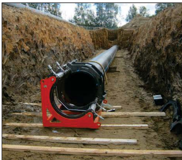
Рисунок 4 – Открытый (траншейный) способ прокладки
