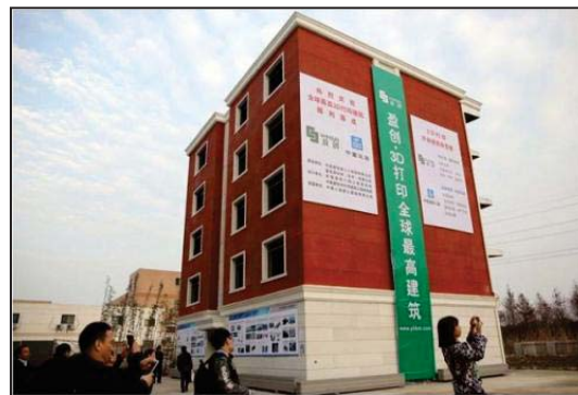
Рисунок 1 – 5-этажный жилой дом, построенный на 3D-принтере
