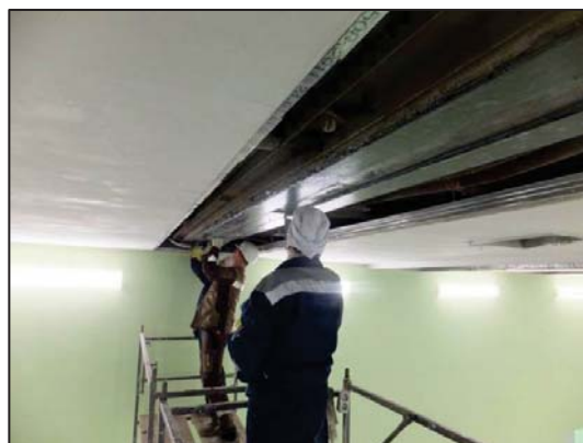
Рисунок 2 – Усиление железобетонных балок чердачного перекрытия средней общеобразовательной школы в п. Балезино-3 углепластиковыми ламелями
