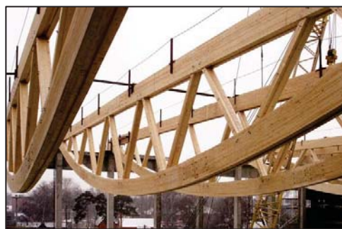
Рисунок 2 – Линзообразные деревянные фермы
