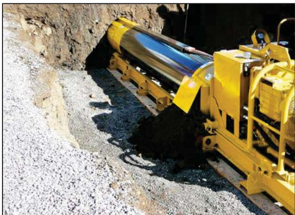
Рисунок 5 – Закрытый (бестраншейный) способ прокладки
