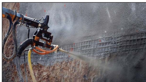
Рисунок 3 – Торкрет-смеси на стенки колодца с помощью ручного сопла
