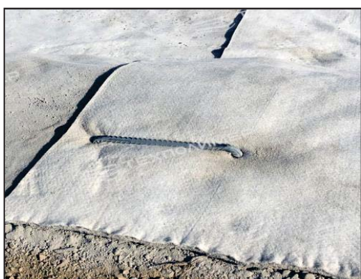
Рисунок 4 – Крепление бетонного полотна
