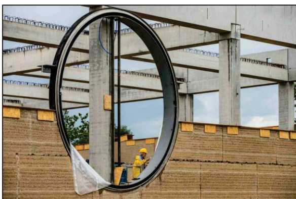
Рисунок 5 – устройство глинобитного фасада Травяного центра компании Ricola
