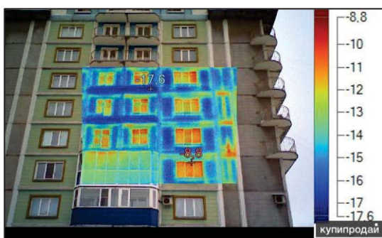
Рисунок 2 – К тепловизионному обследованию ограждающих конструкций
