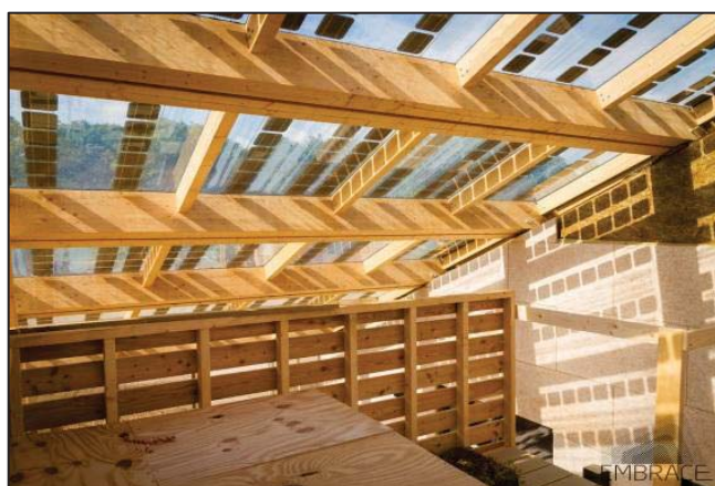
Рисунок 2 – Прозрачная древесина как элемент покрытия
