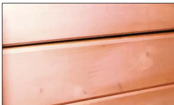
Рисунок 2 – Зазор в горизонтальном шве внутреннего слоя досок
