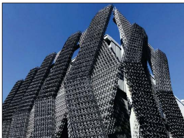
Рисунок 4 – Напечатанные сборочные панели
