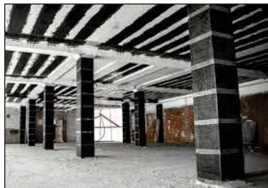
Рисунок 1 – Усиление колонн и плит перекрытия лентами из углеродного волокна
