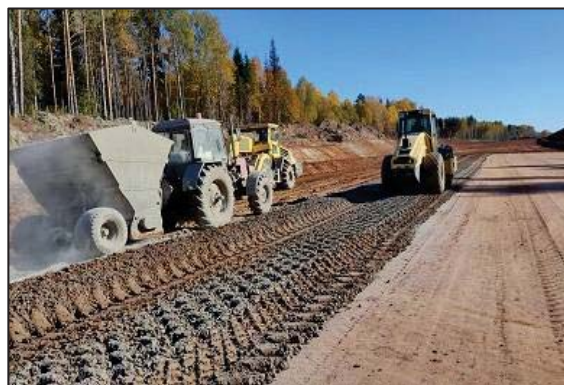
Рисунок 1 – Укрепление дорожных оснований вяжущими
