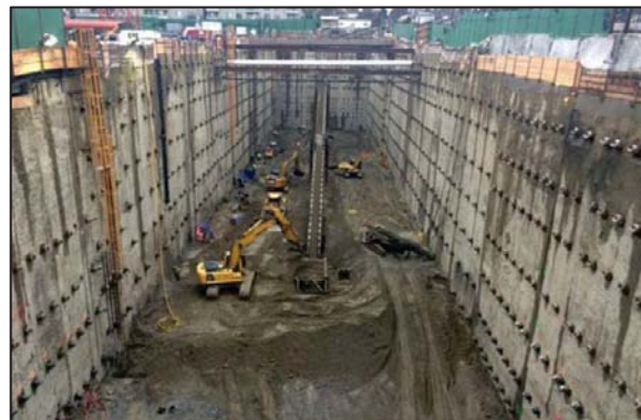
Рисунок 1 – Пример глубокого котлована в условиях городской застройки
