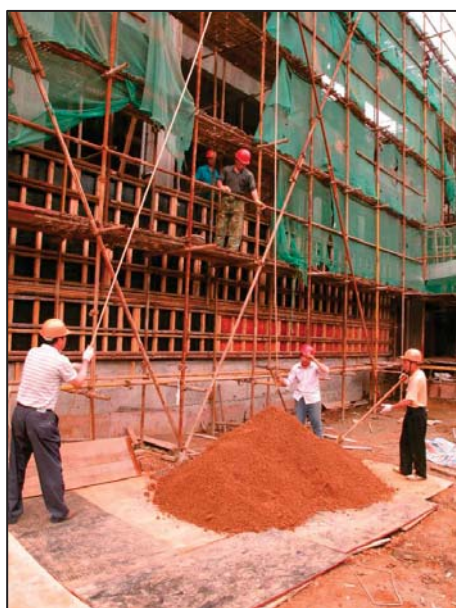
Рисунок 3 – Процесс возведения земляных стен Приемного центра Tiles Hill
