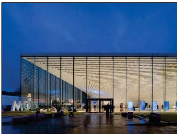
Рисунок 1 – Фасад на стеклянных стойках
