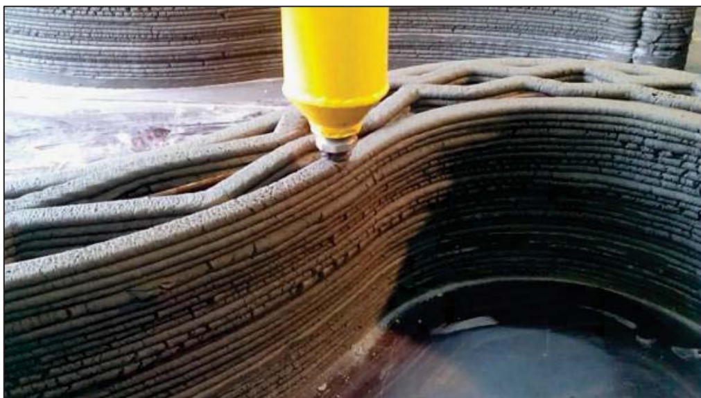
Рисунок 7 – Метод послойного экструдирования с помощью 3D-принтера
