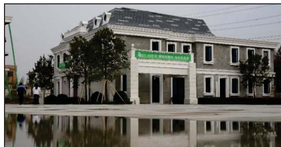
Рисунок 2 – Вилла площадью 1000 м 2 , созданная по технологии аддитивного производства
