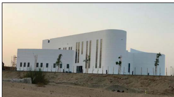
Рисунок 3 – Самое большое в мире здание, построенное в Дубае, напечатанное на 3D-принтере
