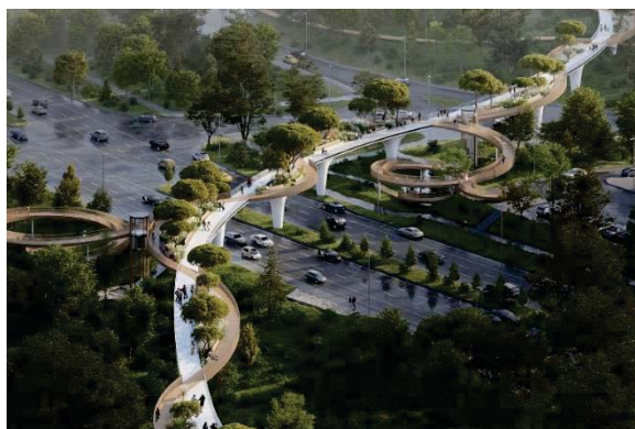
Рисунок 5 – Многоуровневая композиция пешеходного моста архитектурной мастерской «Атриум» в городе Алматы
