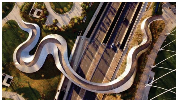
Рисунок 6 – Пешеходный мост ВР – мост в Чикаго, Иллинойс, США
