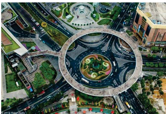
Рисунок 3 – Кольцевой переходный мост в Шанхае, Китай
